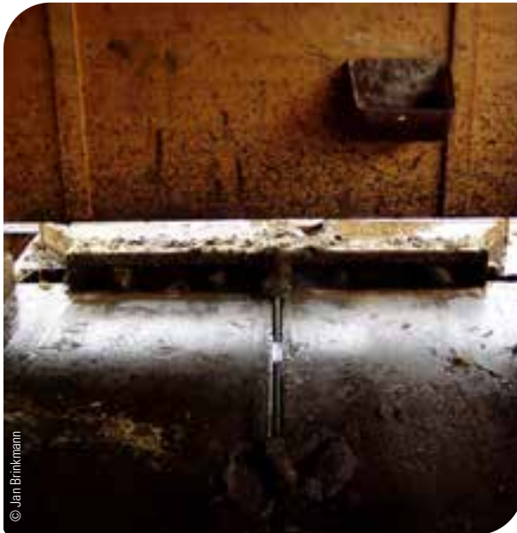
Abb. 62: Entmistungsschieber im Ruhezustand außerhalb des Tierbereichs
