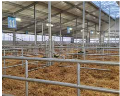
Die Kontrollstation in Trzebieszow, Polen, für die 24-h-Pause ist von der EU zertifiziert und bietet Platz für 600 Rinder. © ZAR/Kalcher
